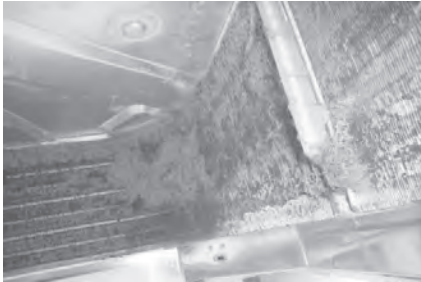
写真 1. 汚染状況 (コイル)
