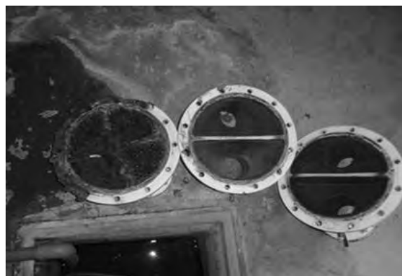
写真2 ヘッダーの状況 (左から給湯系, 昇温 (浴槽) 系, 暖房系)
