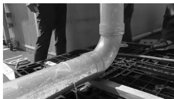
写真 4 上流からの洗浄後堆積状況
