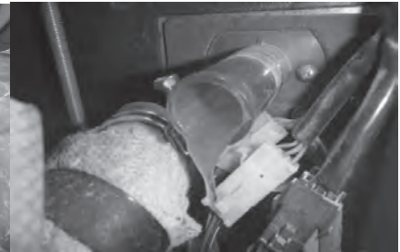
写真 6. 汚染状況 (排水管)
