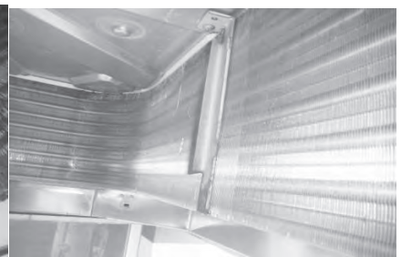
写真 3. 洗浄後 (コイル)
