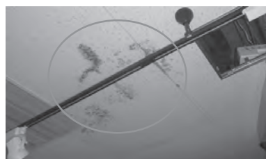
写真 12. 天井ボード漏水
