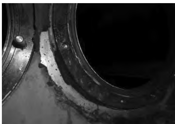
写真3 熱交換器取付用ボルトの状況
