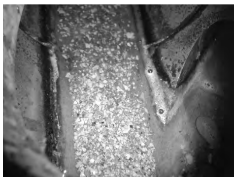
写真 3 築 1 年物件堆積状況
