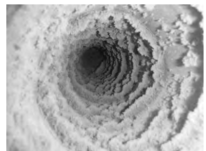
写真7 排気ダクトの汚染
